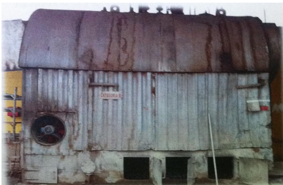
Fonte: JBS S.A. – Cachoeira Alta (2014) FIGURA 19- Caldeira antes da reforma
