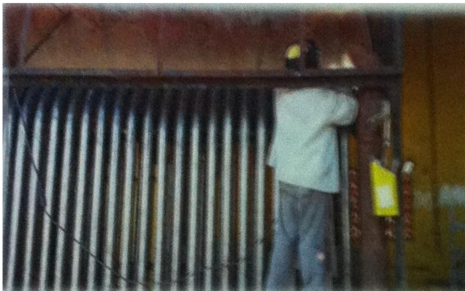
FIGURA 9-Montagem dos novos tubos da fornalha
