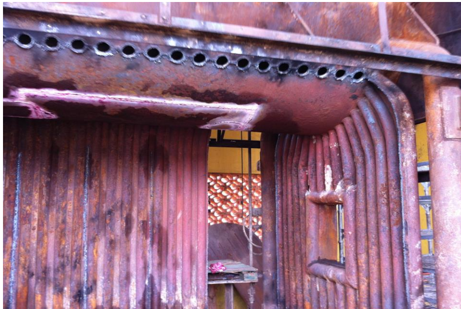
FIGURA 5-Caldeira Mista tipo B- danificação dos tubos.
