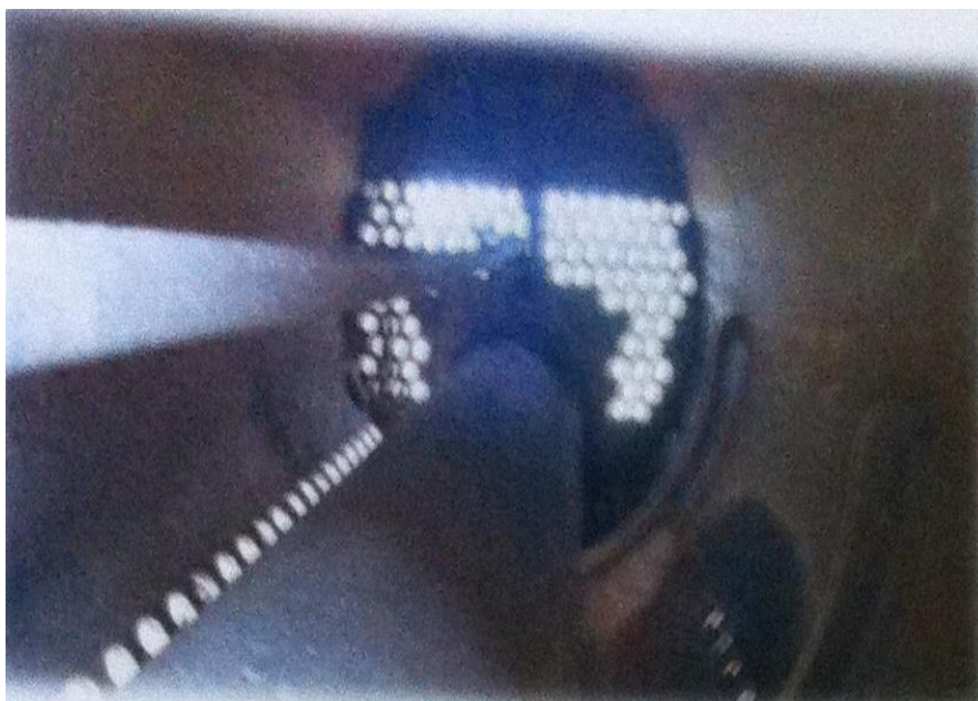
Fonte: JBS S.A. – Cachoeira Alta (2014) FIGURA 7-Balão sem os tubos do feixe
