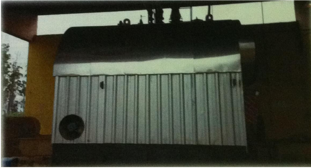
Fonte: JBS S.A. – Cachoeira Alta (2014) FIGURA 20- Caldeira após a reforma
